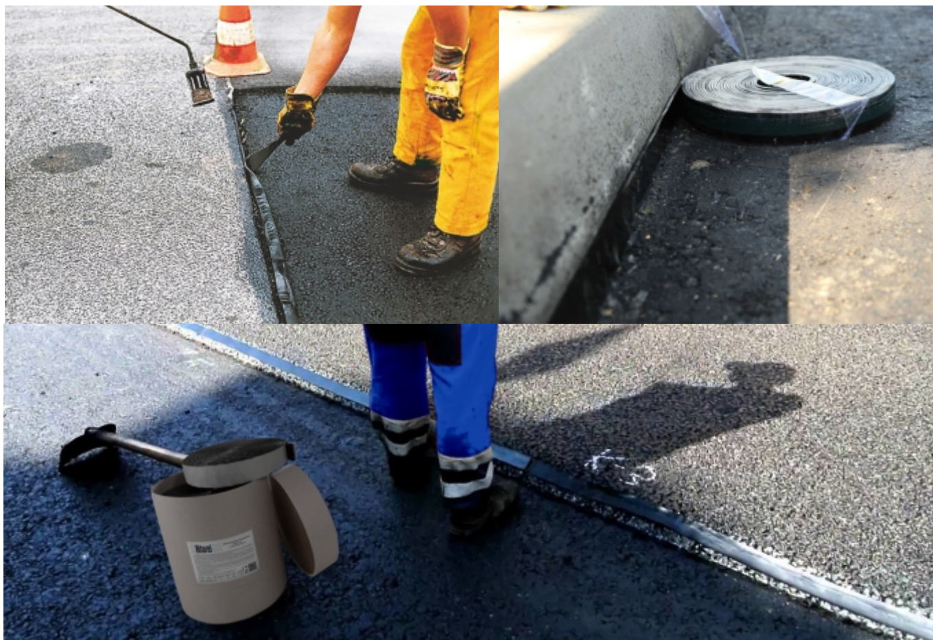
Схема фиксации ленты на кромку холодного стыка при параллельной укладке смежных полос
